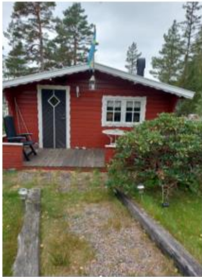
Bild 1 Fritidshus på fastighet samt anlagd grusgång och markplattor.
